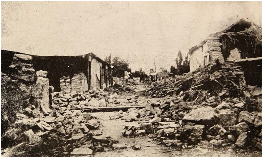
Figura 3: Edificios ruinosos y calles tapadas por escombros luego del terremoto.
